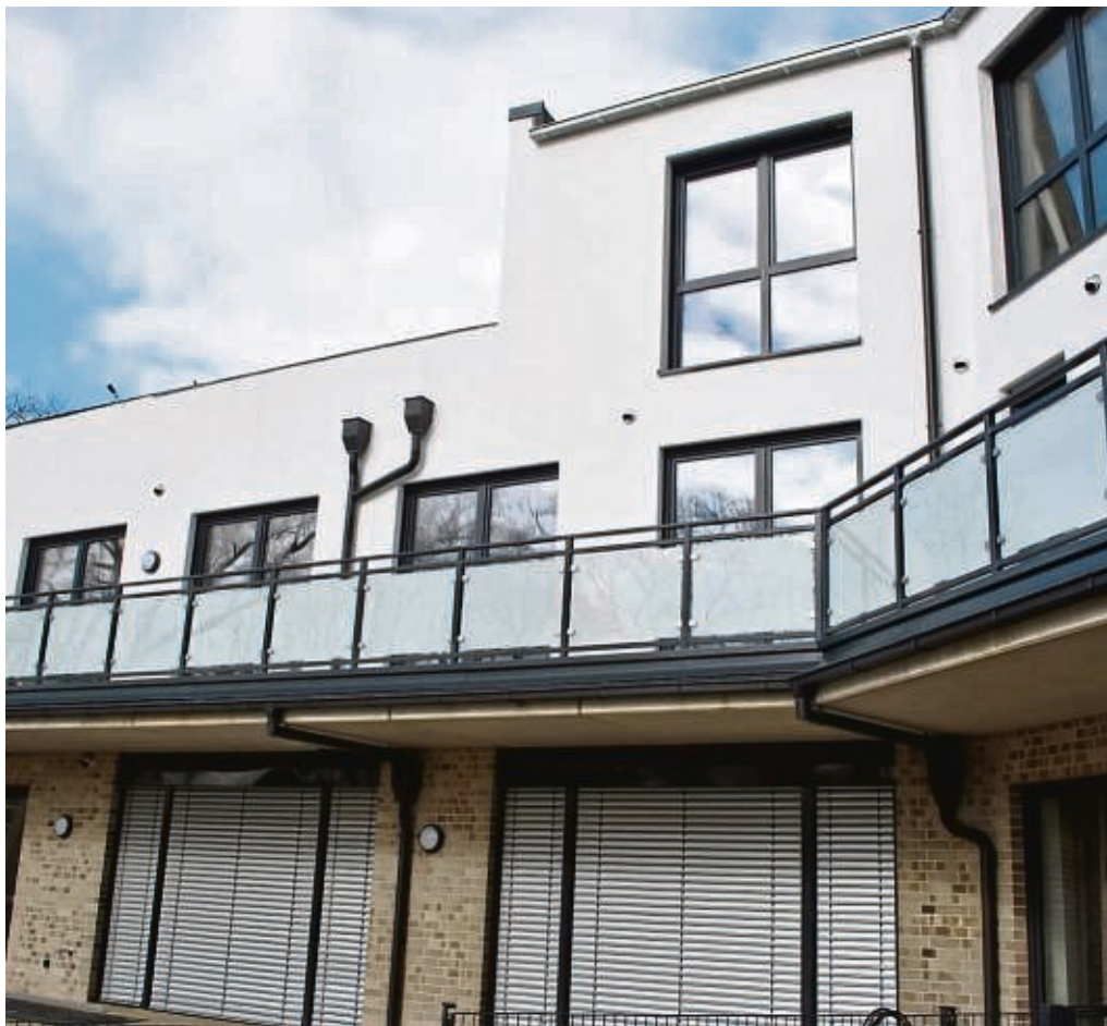
Vorwiegend in der Mitte, aber auch im Obergeschoss liegen die Seniorenzimmer, die auch mittels Aufzug erreicht werden können. Ein umlaufender Balkon lädt zum Verweilen und Klönen ein. Foto: Schubert
