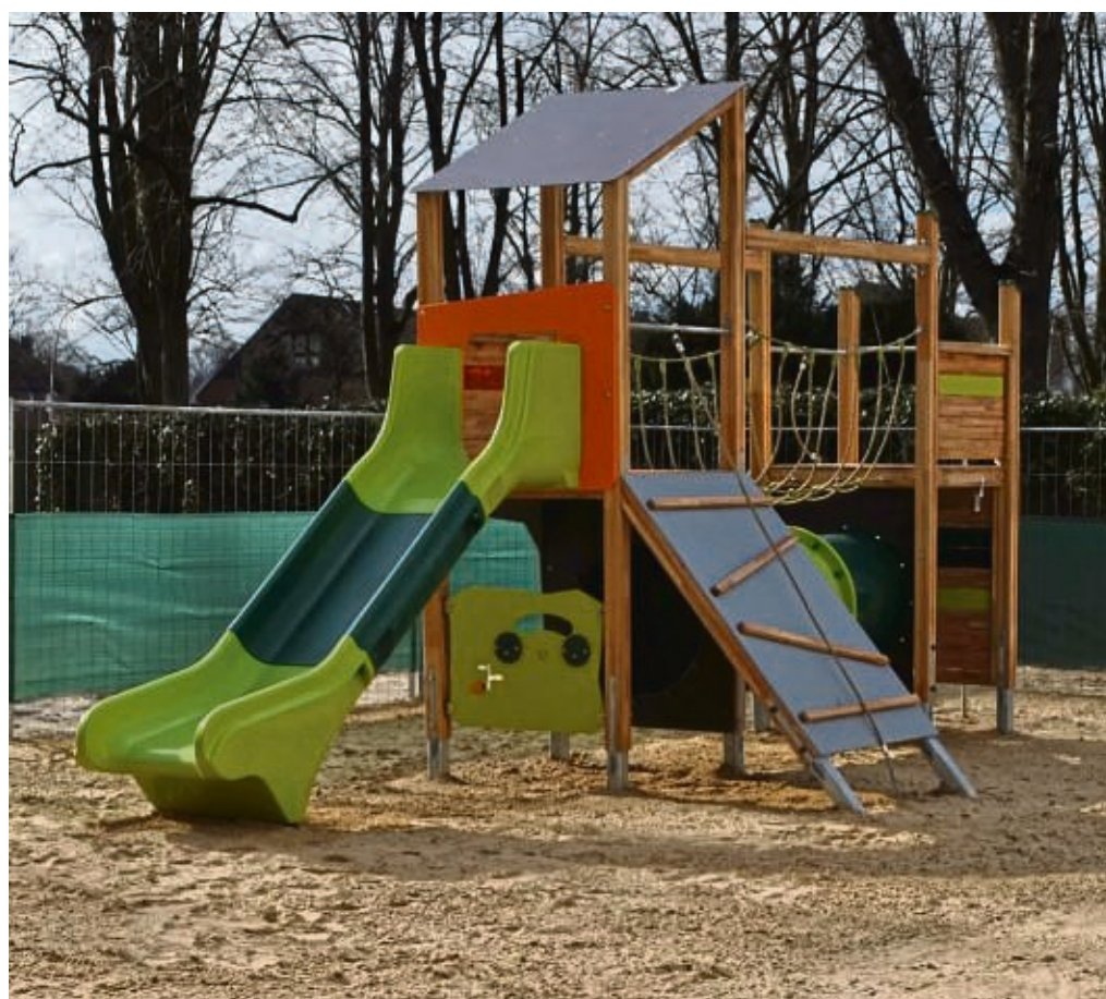
Auch die ersten Spielgeräte auf dem abgezaunten Außenspielgelände sind installiert. Weitere und ein großer Sandkasten folgen noch.
