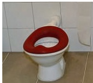
Bei den Sanitäranlagen wurde viel Wert auf Details gelegt.
